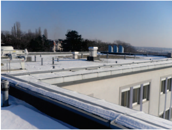
A III. jelű épület tetőfelülete, 1.
