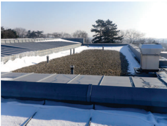
A III. jelű épület tetőfelülete, 2.
