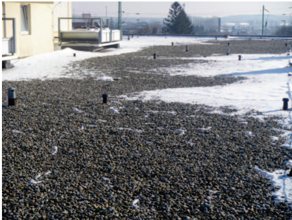
A IV. jelű épület tetőfelülete, 2.
