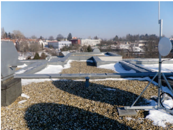
A III. jelű épület kazánházának tetőfelülete
