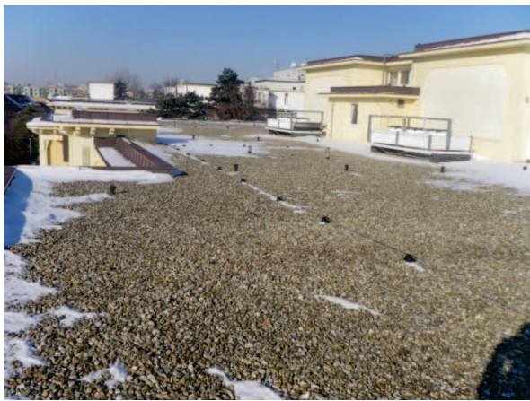
A IV. jelű épület tetőfelülete, 1.
